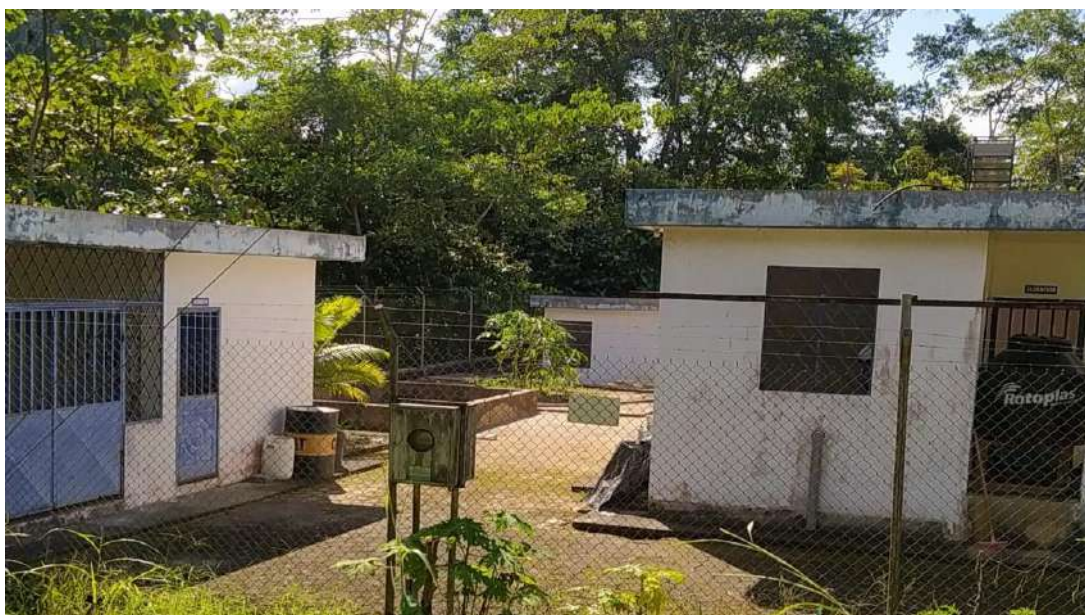
Fotografía 13. Infraestructura de agua comunidad Nueva Unión
