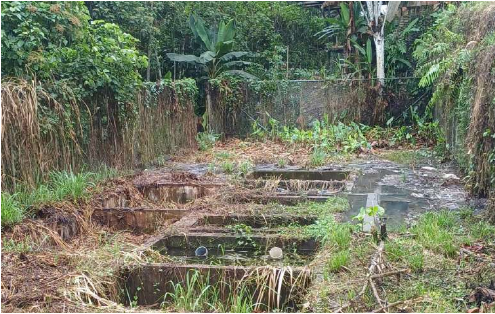
Fotografía 14. Planta de tratamiento de aguas residuales
