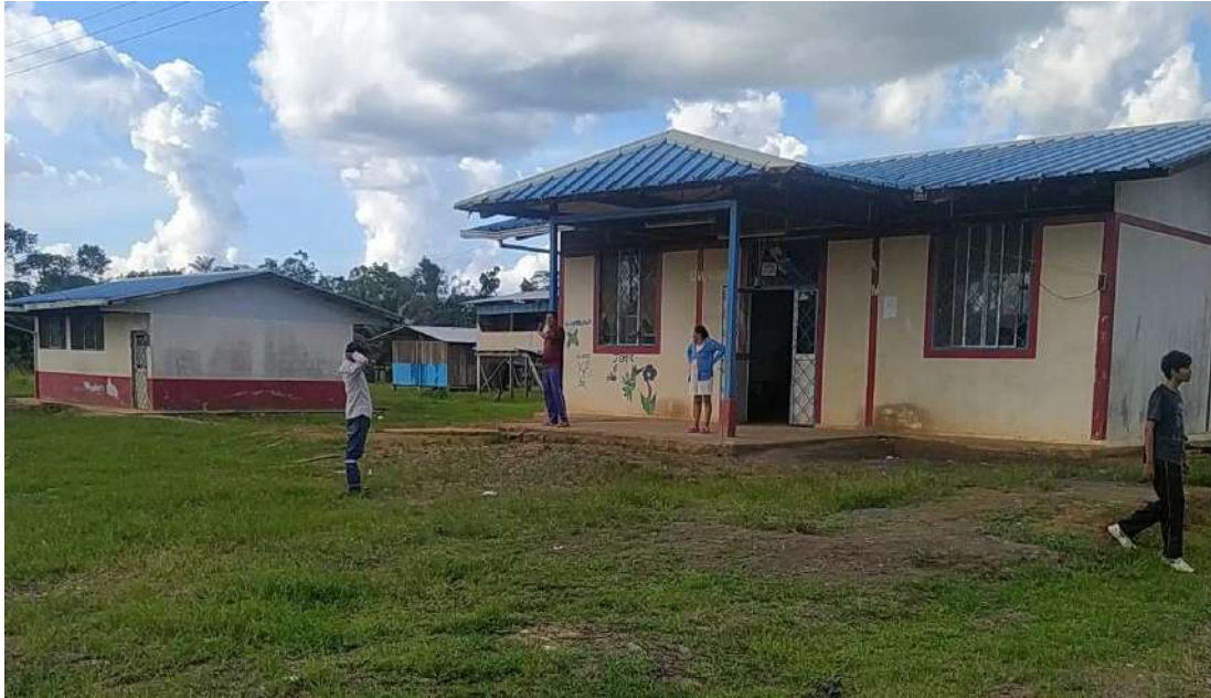
Fotografía 7. Albergues: casa comunal comunidad Tiwano
