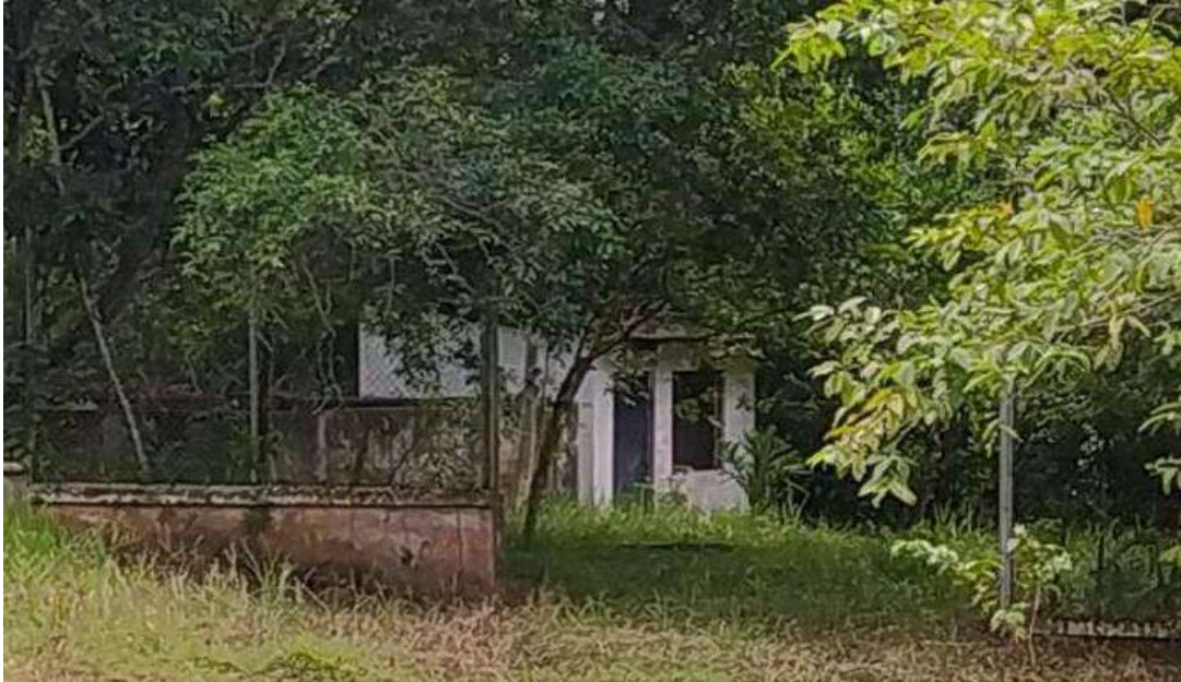
Fotografía 12. Infraestructura de agua comunidad Azuay
